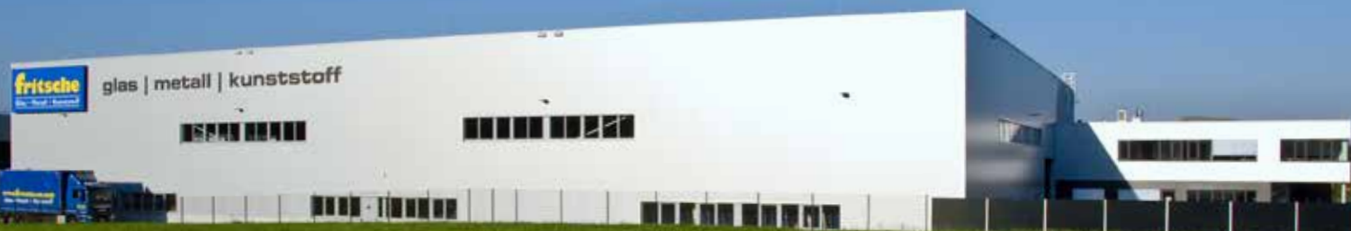
Firmenhauptsitz | Anthering IV | Bereich Glas
